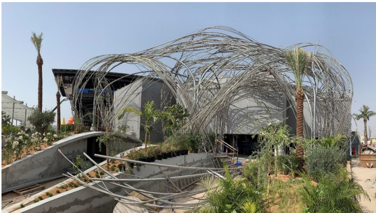
Ocelové kapiláry obepínající český pavilon mají celkovou délku 17 kilometrů.
